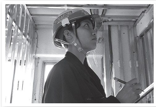
マンションの建設現場にて
